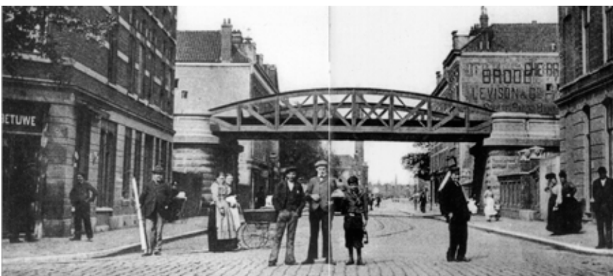
De in 1884 aangelegde Oranjeboomstraat (blz. 47) was opgevat als een brede boulevard: door een bomenrij gescheiden rijbanen met tramrails, brede trottoirs met bomen en aaneengesloten gevelwanden. De eenvoudiger opgezette Rosestraat (blz 49) kreeg een breedte van twintig meter met bomen aan weerszijden en werd alleen aan de oostzijde bebouwd. Aan de overzijde lag het spoor van de RTM en stond de afscheidingsmuur van het RHV handelsterrein. Tussen de Oranjeboomstraat en de Rosestraat liep het spoor, deels verhoogd op een dijk met onderdoorgangen zoals hier links in de Roentgenstraat (bron: Buijn, 2006).
