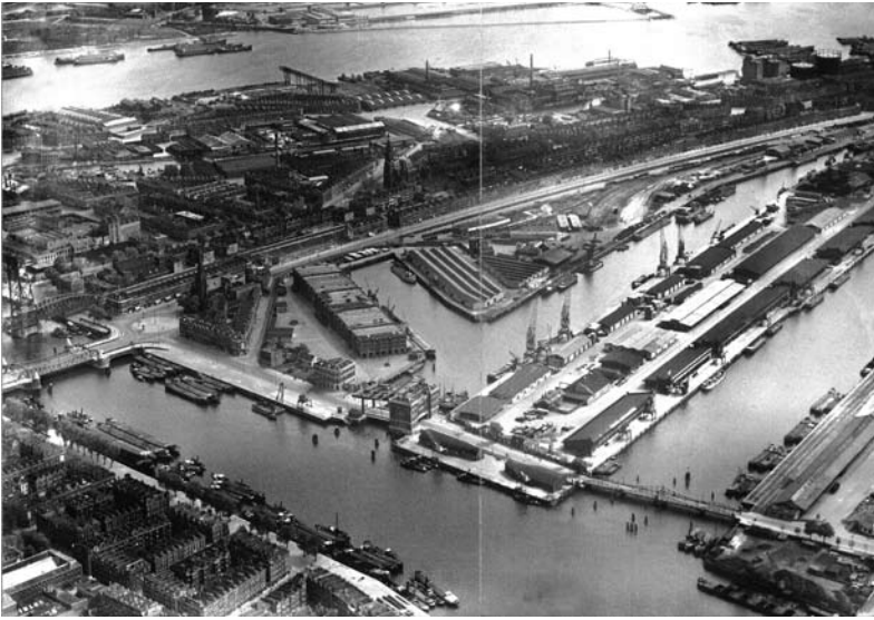
Luchtfoto over het handelsterrein van de RHV met in het midden de Entrepot haven met het pakhuis De Vijf Werelddelen. Aansluitend de Binnenhaven met op de kop het zgn. Poortgebouw. Rechts hiervan de landtong met kades, kranen, sporen en loodsen en de Spoorweghaven. Een grote, gemechaniseerde 'machine' voor de overslag van bulkgoederen (bron: Bruijn, 2006).
