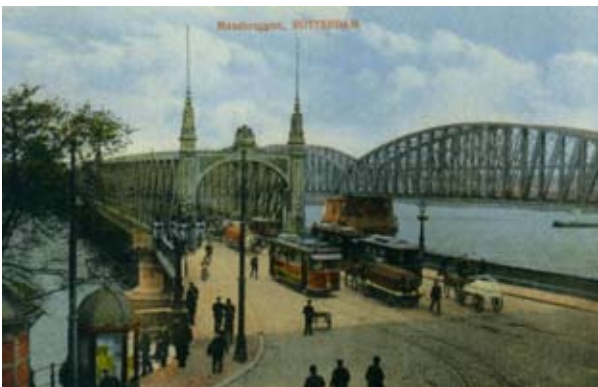
De Willemsbrug 'IJzeren Willem' en de spoorbrug over de Nieuwe Maas gezien vanaf de Maaskade in 1920 (bron: GAR).
