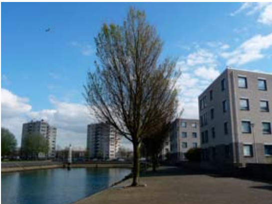
Het complex met de drie woontorens ter plaatse van de vroegere Veilinghallen op de Persoonsdam (Architectenbureau Groosman, 1989-1990).
